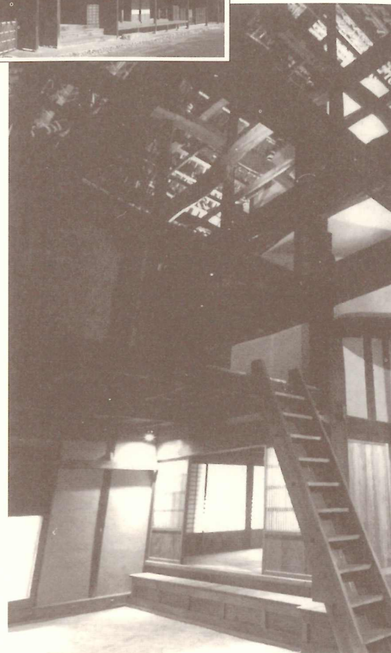
土間から天井裏を仰ぎ見たところ。屋根裏に続く重層的な建物構造をここから見る事ができます。1階左手が畳敷きの広間、右手が板張りの囲炉裏付き茶の間です。大きく曲った梁（箆子梁=しんしばり）の向う側、囲炉裏の上に煙出しがあります。茅葺き屋根を外から見ると煙突のように見える、それが煙出しです。（主屋の写真参照）
