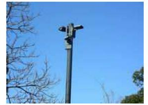
本郷ふじやま公園の古民家には茅葺屋根の火災を外側から検知する「フレームチェッカー」が設置されています。これは炎が放射する紫外線と赤外線の変化量を検出し、火災の発生をとらえます。主屋と長屋門の茅葺屋根に向かって、前後左右からいくつかの感知器が監視しています。感知器を搭載したポールが6本あり1本のポールに数台、全部で12台の感知器が設置されています。誤作動を考慮して2台が同時に感知して火災と判定し、ドレンチャーが作動します。
