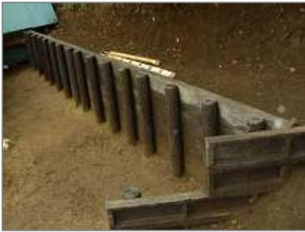
炭焼き広場の農園側からの入口から入った左側の山が従来から少しずつ崩れてきていました。そのため、雨降りの日には土砂が広場に流れ込み、滑りやすくなっていました。そこで山際に高さ約1m、長さ約10mの偽木の土留め工事が完成しました。これで農芸部
