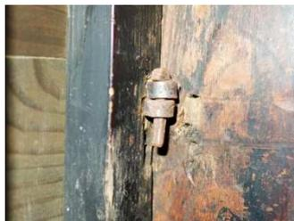
じつぽ)に、観音扉に付けた肘金物・肘金(ひじがね)をさし込んで、丁番のように開閉させます。肘壺金物は観音扉左右の各々上下に計4組が設けられています。
