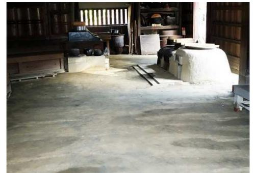
たたきは「敲き土(たたきつち)」の略で、赤土・砂利などに消石灰とにがりを混ぜて練り、塗って敲き固めた素材です。三種類の材料を混ぜた合土(アサチ)から「三和土」と書きます。セメントが普及するまで土間の床に使われました。明治期に、改良した三和土が、湾港建築や用水路開削などの大規模工事にも用いられました。
