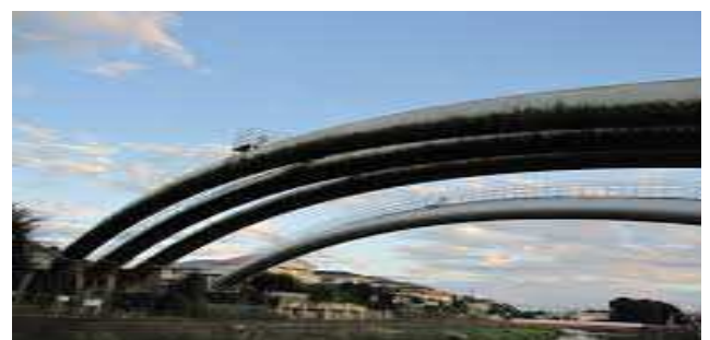
導水管の美しいアーチ
